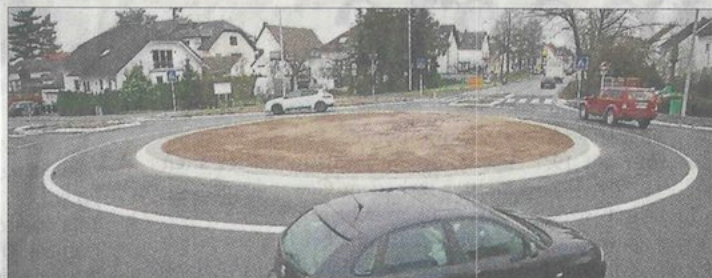
Vor einem Jahr wurde der Kreisel eingeweiht. Wie er mal aussehen wird, ist noch unklar.
